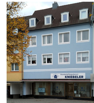
Beispiel einer Fassadensanierung
