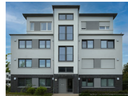
Beispiel einer zeitgemäß gestalteten Putzfassade
