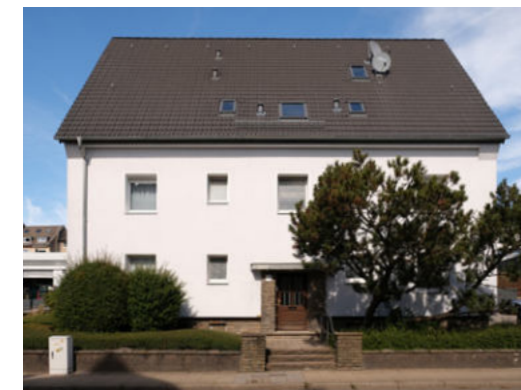
ortstypisches Satteldach ohne Dachaufbauten
