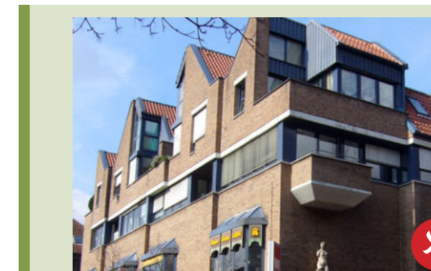
dominierende Dachaufbauten beeinflussen die Dachlandschaft negativ
