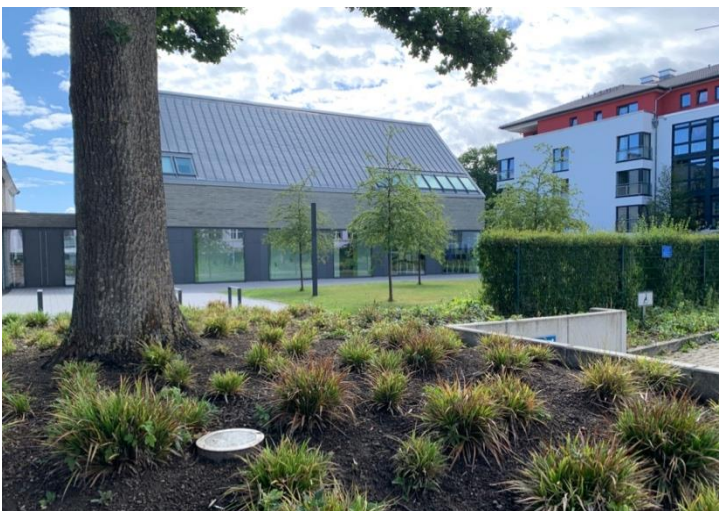
Abb. 23: Neues Gemeindehaus und Kirchenvorplatz
