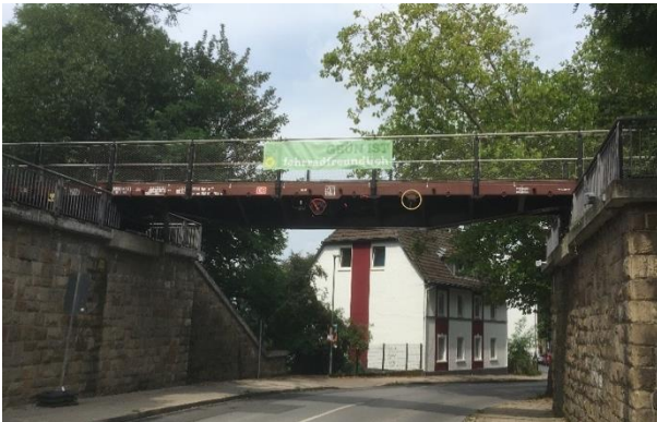
Abb. 47: Waggonbrücke und Alte Silos
