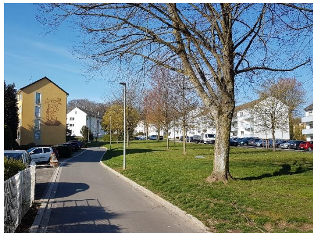
Abb. 47:Stettiner Straße (Nonnenbruch)
