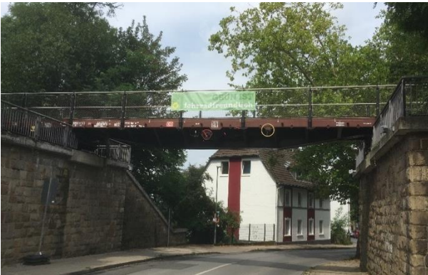
Abb. 47: Waggonbrücke und Alte Silos
